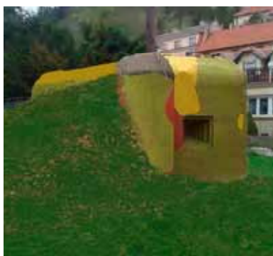
REKONSTRUKCE BUNKRU Z ROKU 1938
